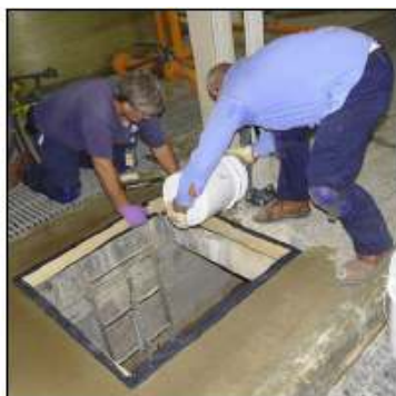
Възстановяване формата на отвора за достъп към площадката
