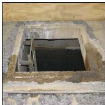
Подът е подготвен за полагане на покритието
