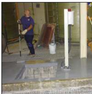
Полагане на Belzona® 5811 заедно с добавен противоплъзгащ агрегат
