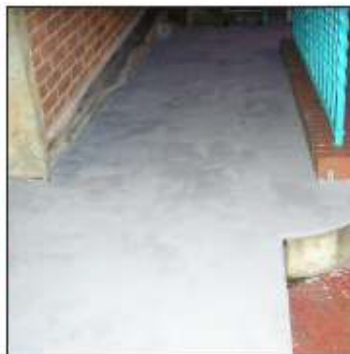
Възстановената с Belzona® 4131 повърхност
