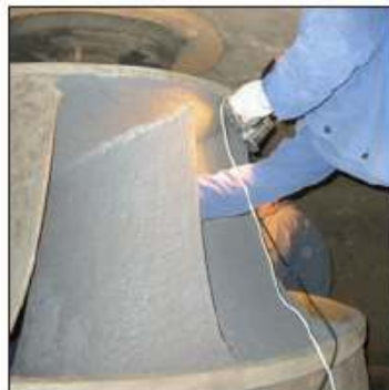
Въстановяване с Belzona® 1111
