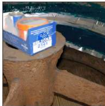
Ремонтираната повърхност с направени намалителни канали, ограничена с тиксо и наполовина покрита с Belzona® 2141
