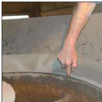
Степен на повредата от кавитация по смукателя, под и над носещия пръстен
