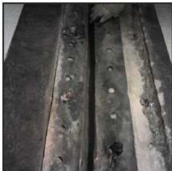
Изглед от фугата след отстраняване на покриващите плочи
