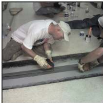
Полагане на Belzona® 2221
