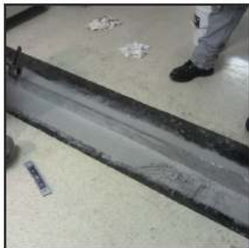
Полагане на Belzona® 4111
